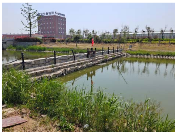
排污口上游九支河新建常闭闸
