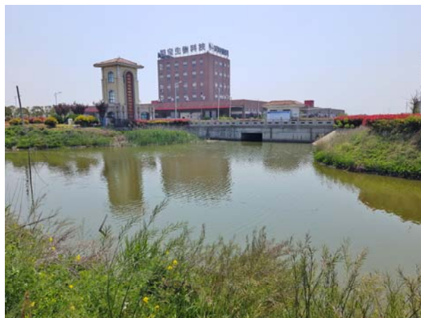
海堤河常闭闸
