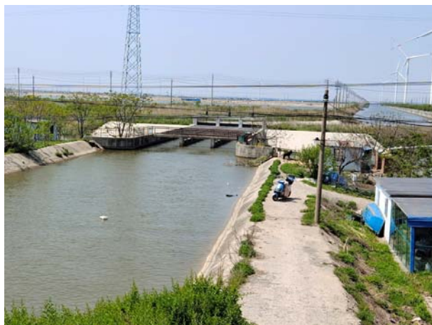
射阳盐场总送水渠（上跨海堤河处）
