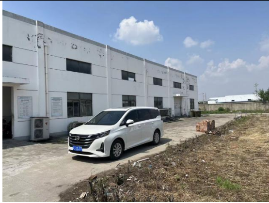
动力蓄电池拆解车间现状
